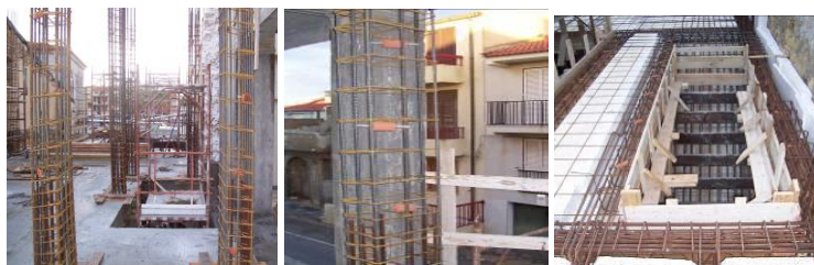
Applicazione di GSC SuperAnode su strutture nuove
